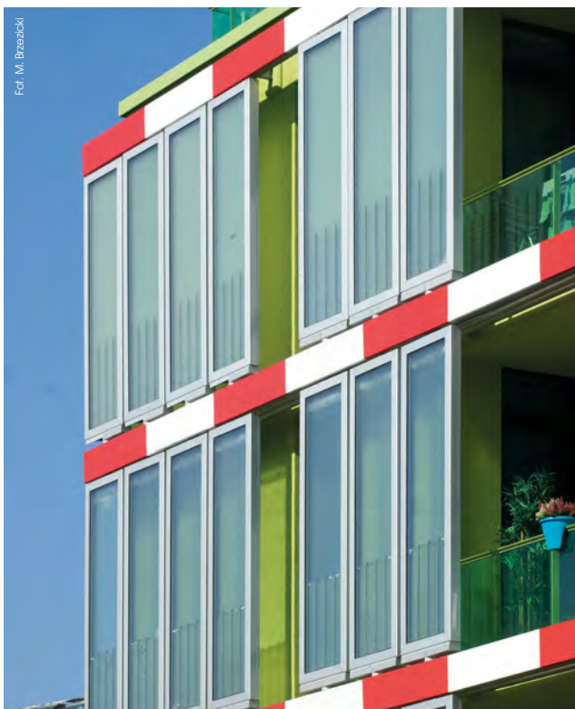
Fot. 3. Budynek mieszkalny BIQ, IBA Hamburg. Widoczne bioreaktory, w których algi fotosyntetyzują, produkując biomasę (arch. Spiitterwerk, 2013)
